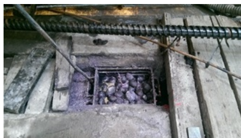
Figura 1: Punto de recolección de la muestra de agua residual de curtiembre. Se observa una caja rejilla con sustrato filtrante (rocas) con el fin de retirar pelos y carne procedente del proceso de pelambre. El flujo del agua es de izquierda a derecha y la muestra fue recolectada en la salida de la caja.
