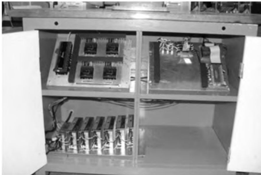
FIGURA 7 Montaje de los elementos del sistema de control
