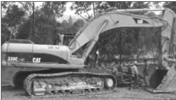
FIGURA 2 Excavadora sobre orugas
