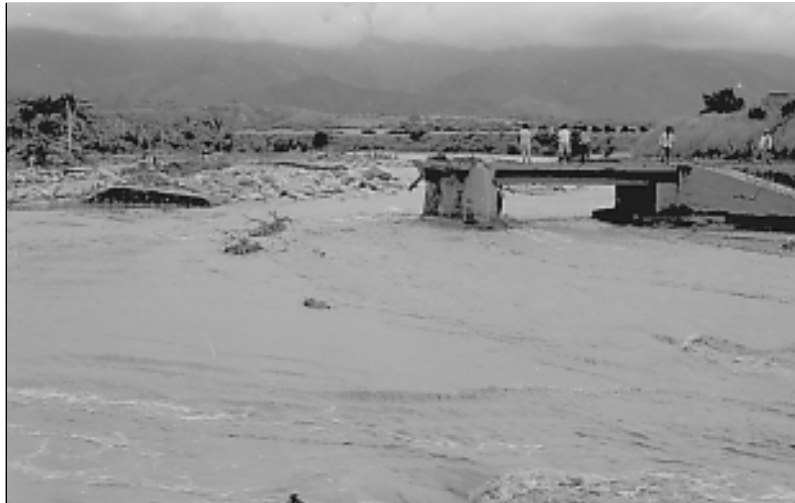
Figura 9 Puente destruido sobre el Río Fraile, al sur de Florida, hacia el poblado de Miranda. Troncos y bloques se acumularon debajo del puente y provocaron su destrucción
