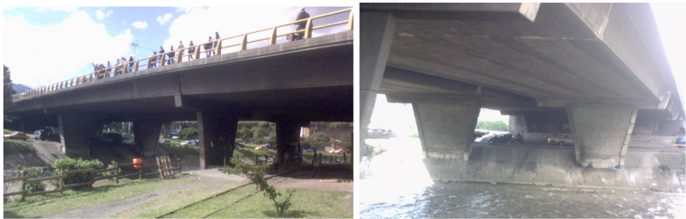
Figura 14: Fotos del puente vehicular de San Juan sobre el río Medellín.
