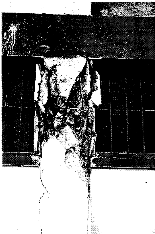
FOTOS No. 2 y No. 3 Fallas de columna corta, Armenia (Quindío), Enero de 1999
