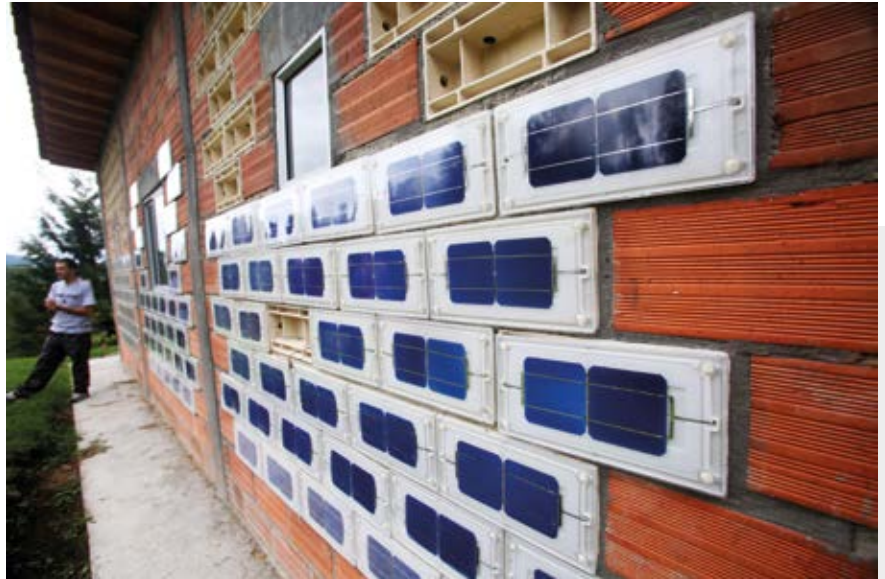
El ladrillo solar permite suministrar iluminación y energía a edificaciones a bajo costo. Foto Robinson Henao.
